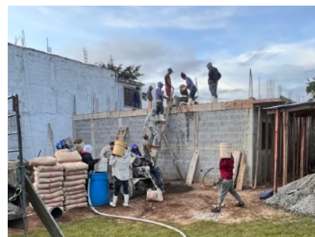
Pouring the cement roof
